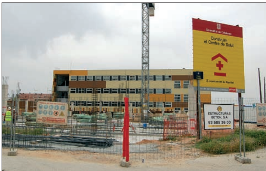
LES OBRES VAN COMENÇAR EL PASSAT FEBRER
